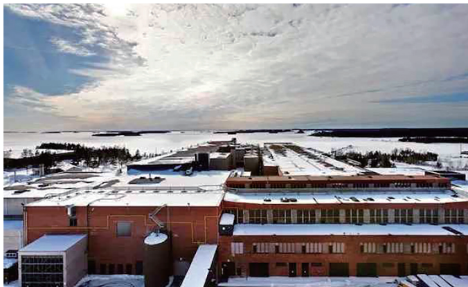
그림14 핀란드 하미나시에 위치한 구글의 데이터센터. 주변의 차가운 바닷물을 끌어와 데이터센터를 식힌다. / 출처: 조선비즈
